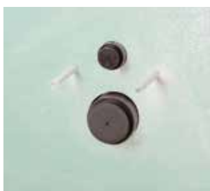
Защитная заглушка просто надевается на канализационный патрубок.
