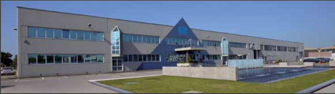
Remer главный офис и фабрика.
