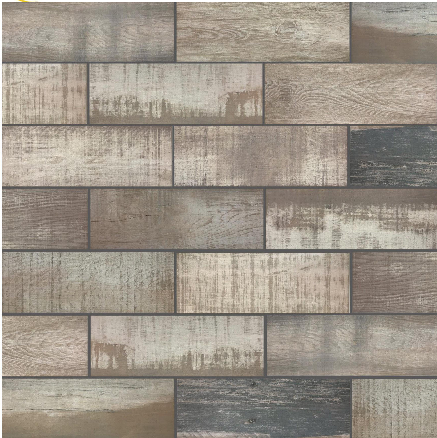
Участок пола с керамической плиткой Baldocer Carson из нескольких упаковок одной партии
