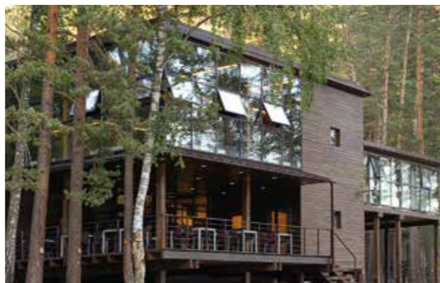
Гостиничный комплекс «Алтिका-Алтай» г. Алтай, 2020 г.
